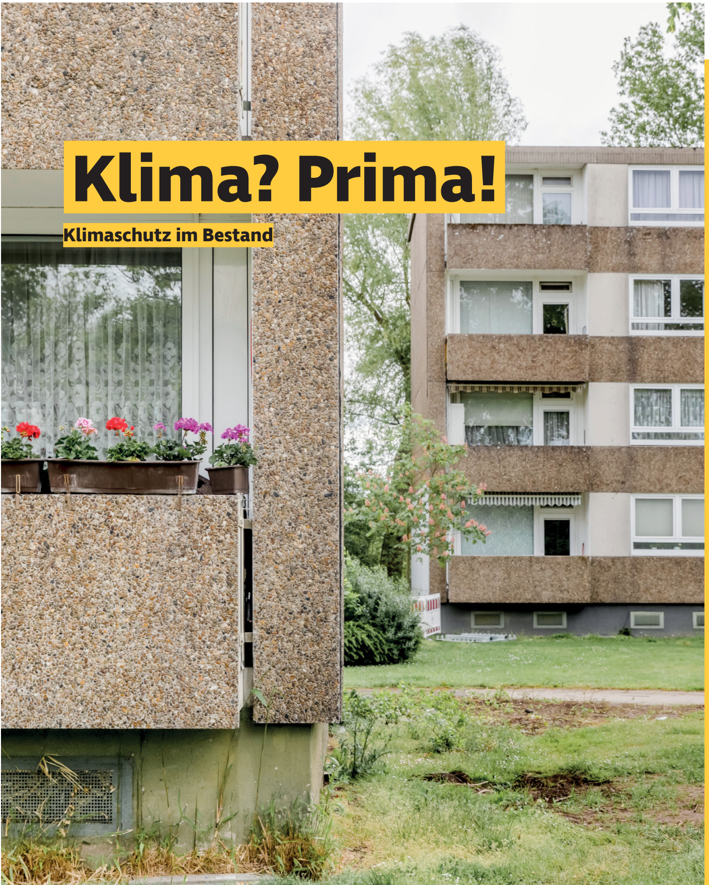
Gebäude in der Kissinger Straße vor der anstehenden Modernisierung.
