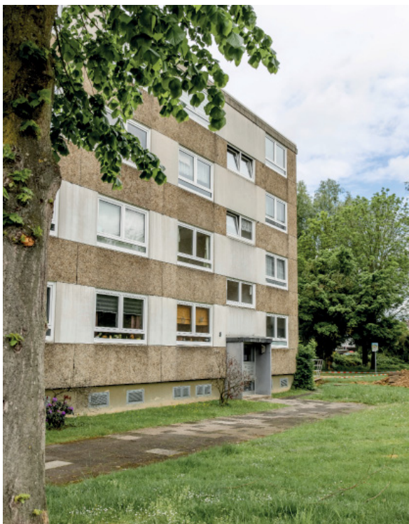
Mind. 2,5 Jahre wird das Sanierungsprojekt in der Kissinger Straße Düsseldorf dauern.
