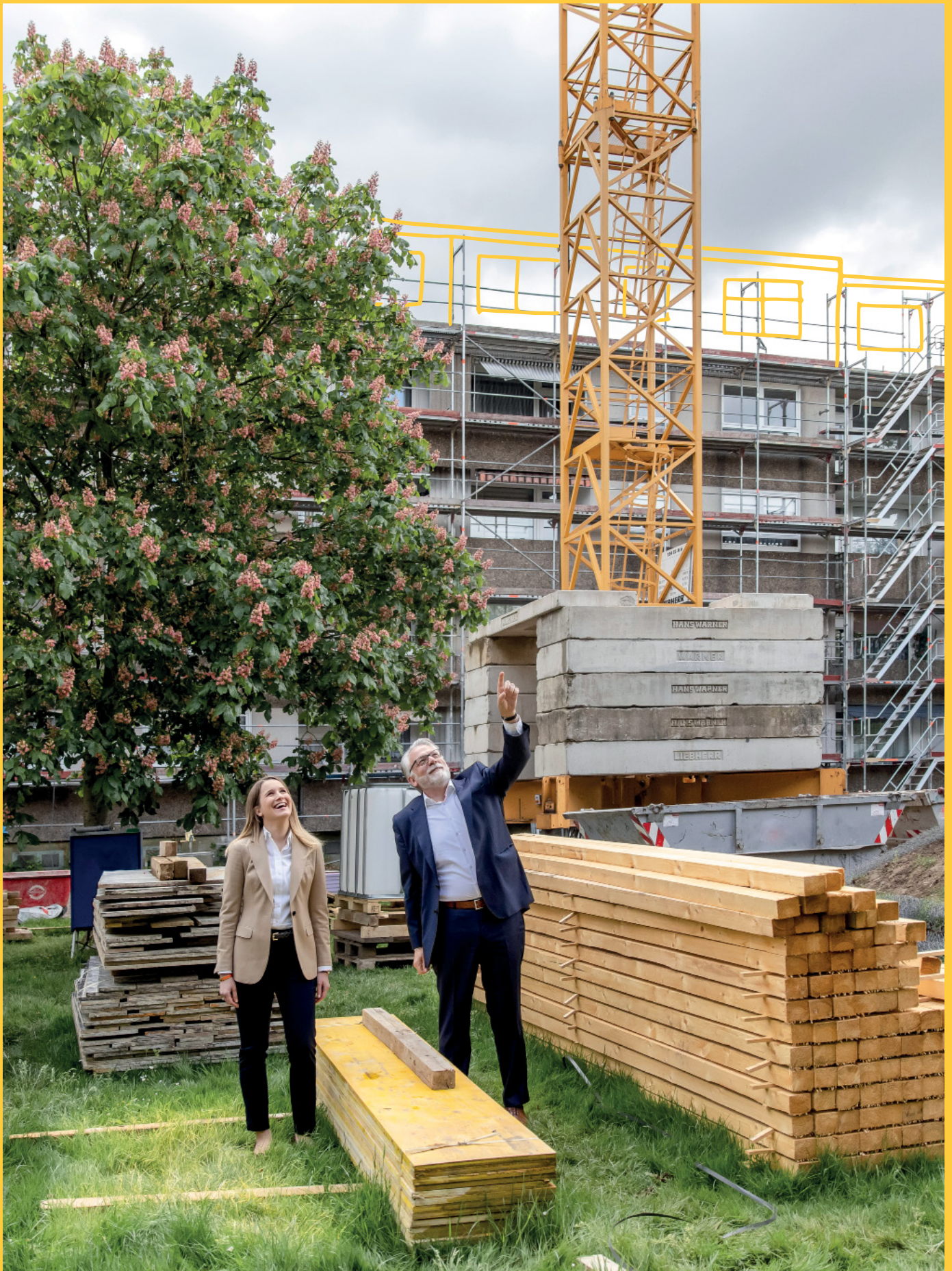
Lara Forsbach und Peter Sarach begutachten die Baustelle.
