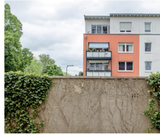
Ein Teil der Siedlung ist bereits in einer vorherigen Sanierungsphase modernisiert worden.
